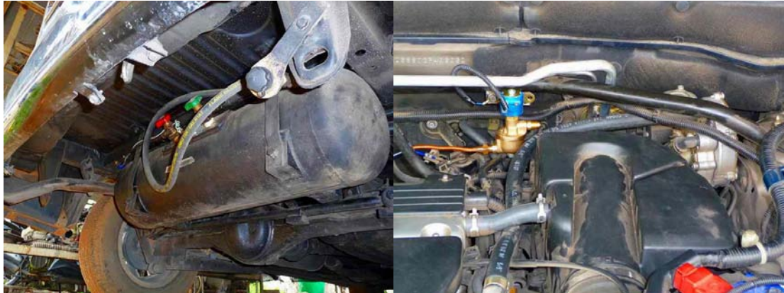
図1 天然ガス車（NGV）のガスタンクや改造したエンジンルーム
